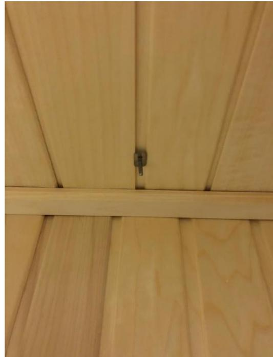
温度センサーを天井に設置する場合には最低でもサウナ本体から 300mm 離して設置して下さい。
